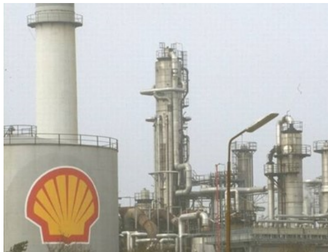
Et af de store projekter vi har deltaget i er Shut-down projektet på Shell Raffinaderiet i Fredericia
